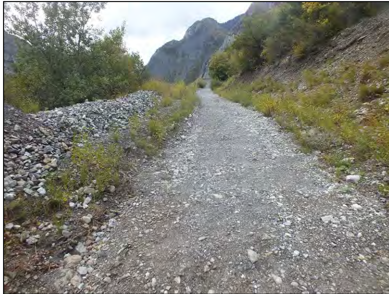
Merlon au niveau de l'accotement aval de la piste d'accès
