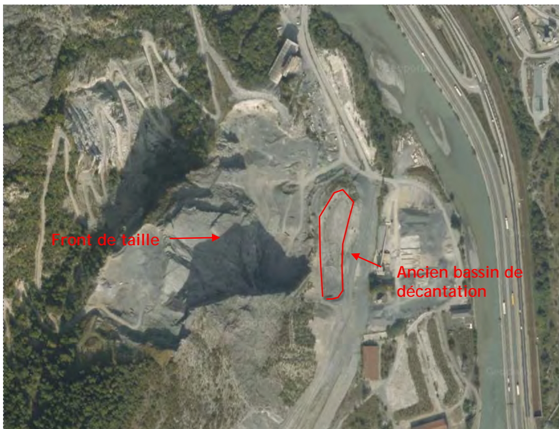
Figure 2-21 : Emplacement de l'ancien bassin de décantation
