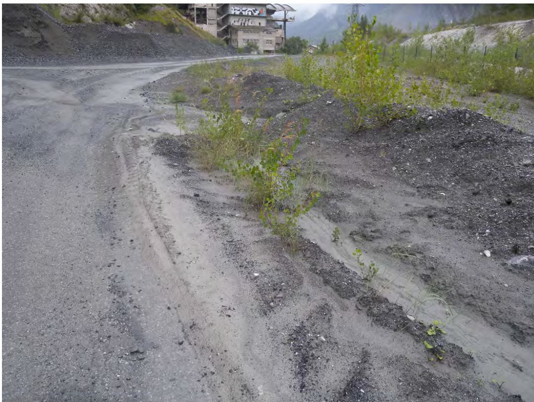
Figure 2-16 : Ruissellement en bord de route
