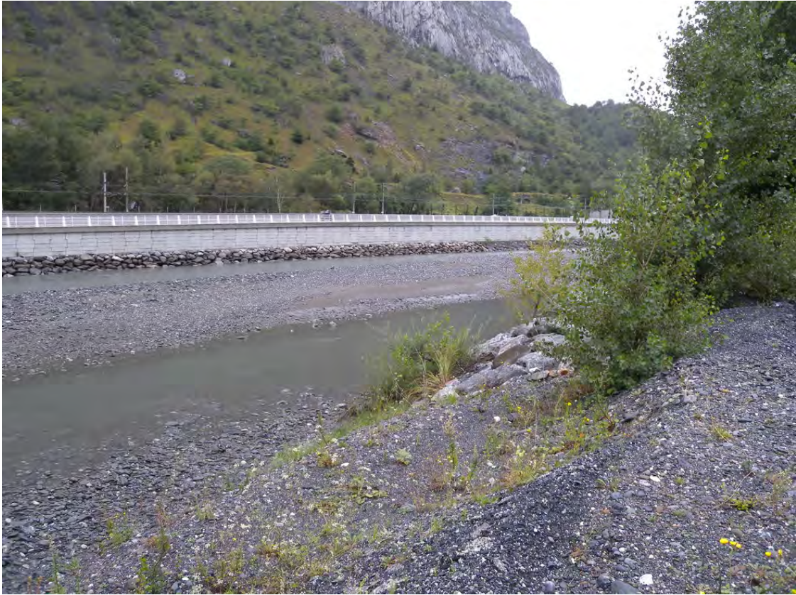
Figure 2-5 : L'Arc et sa rive droite en appui contre l'A43
