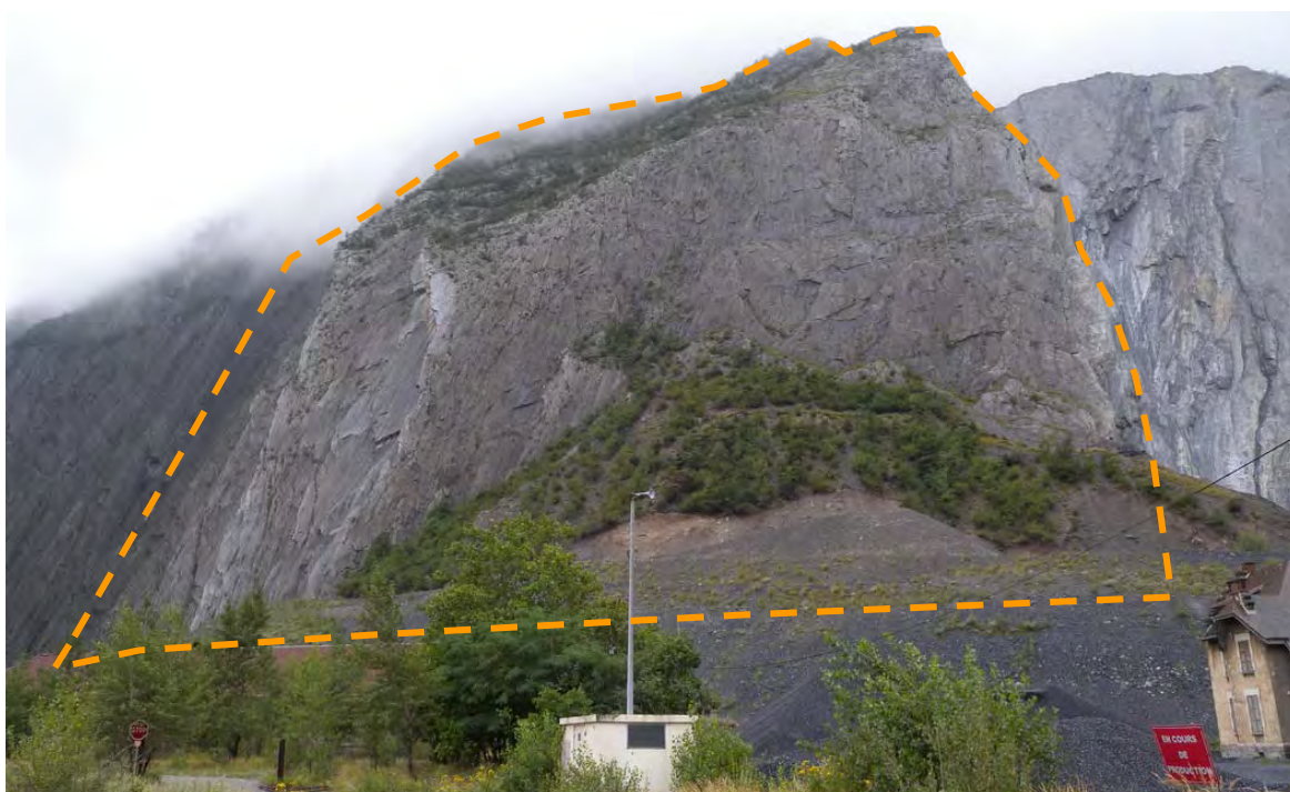
Figure 3-1 : Vue approximative de l'extension du front de taille
