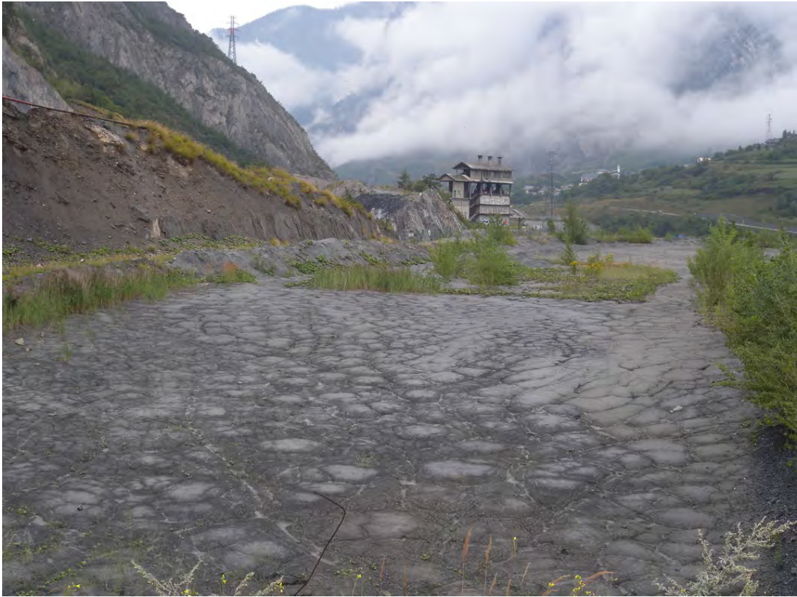
Figure 2-22 : Bassin de décantation
