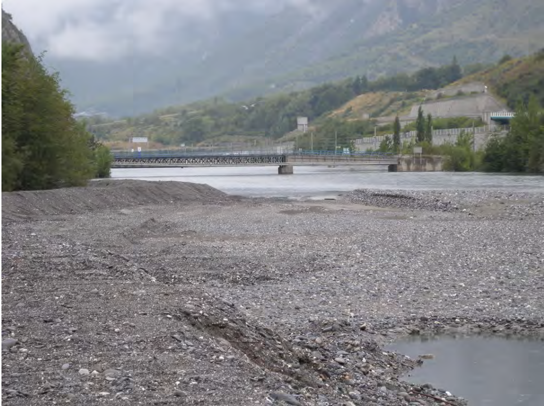
Figure 2-6 : L'Arc et le pont d'accès à Calypso
