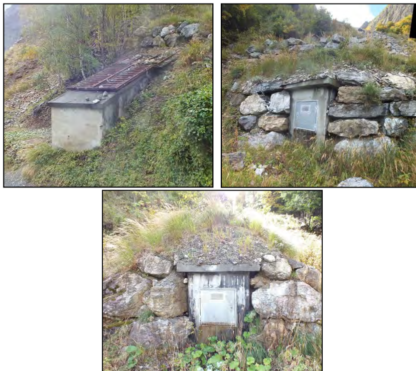
Vue des trois brises-charges présents dans le versant, dans l'emprise de notre zone d'étude
